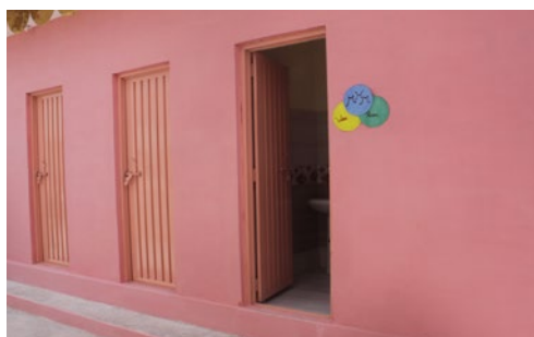
Von links nach rechts: Hygieneerziehung anhand S4M Lernmaterialien / Gendersensible Sanitäreinrichtungen unter Berücksichtigung von Menstruationshygienebedingungen an der UC Baleli
